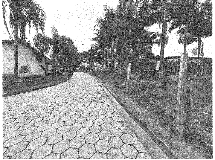
Foto 03 – Vista logradouro lado direito.
