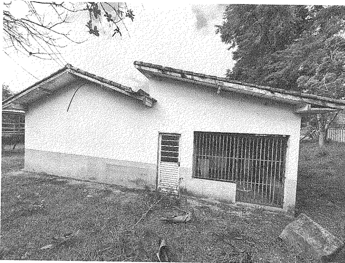
Foto 06 – Vista lateral da Edificação.
